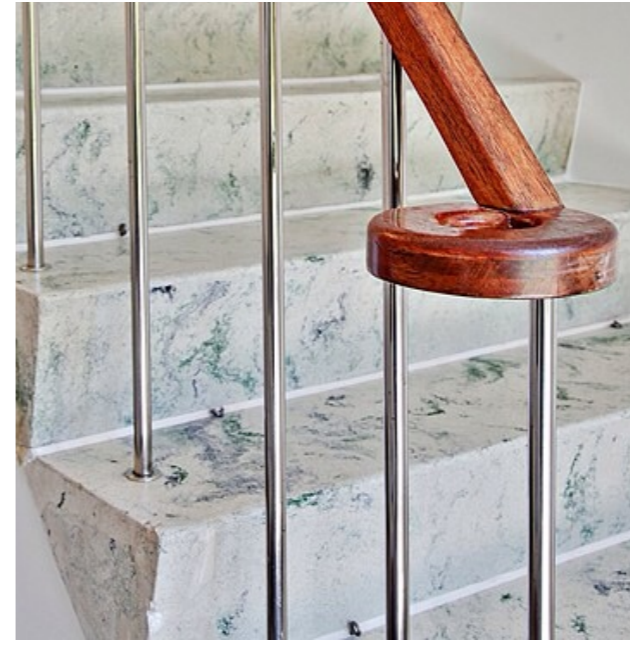
Betongtrappa klädd med terazzo. Handledare i trä.
