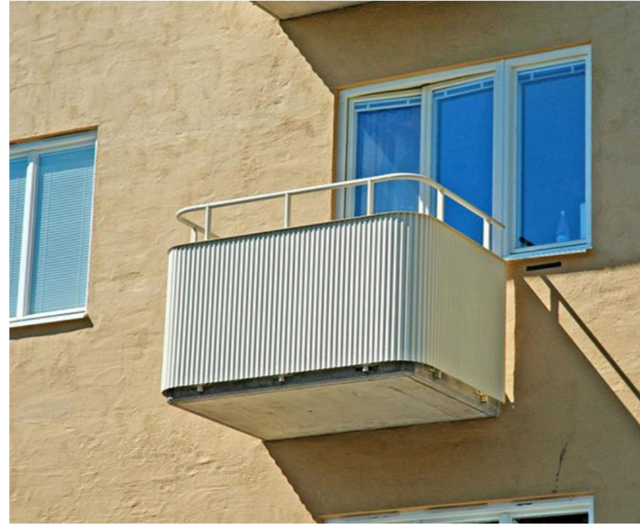
Balkonger med rundad plåt vid hörn
