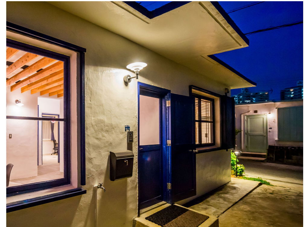
Yttervägg vid entré
